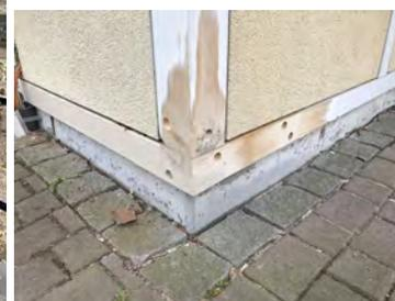
An den drei Gebäuden am Haupteingang gegenüber der Freiluft Halle wurden die morschen Holzstellen ausgetauscht und anschließend neu gestrichen. Des Weiteren wurden ebenfalls die Dachsparren kontrolliert und die notwendigen Reparaturen durchgeführt.
