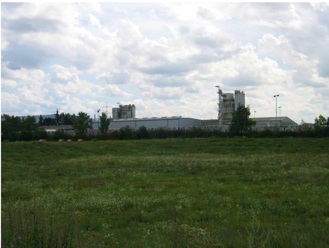
Bild 6: Blick von Norden über das Versickerungsbecken auf die Nordgrenze des vorhandenen Industriegebietes
