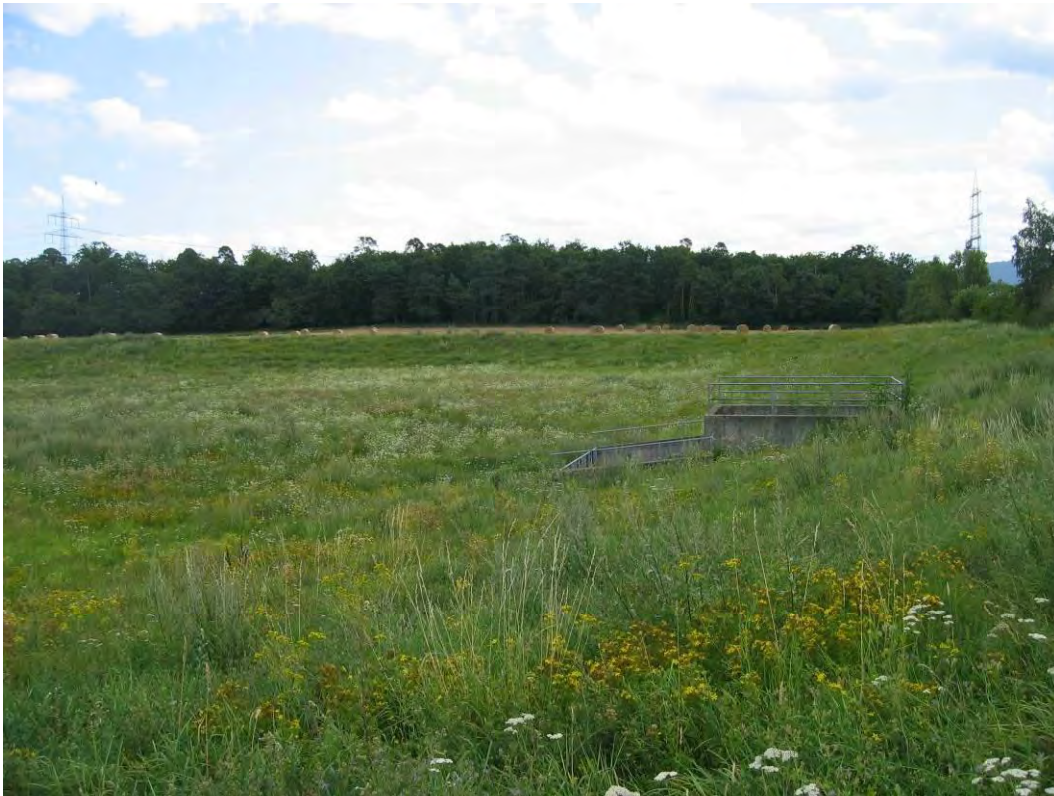
Bild 5: Regenwasserbehandlungsanlagen im mittleren Bereich des Planungsgebietes
