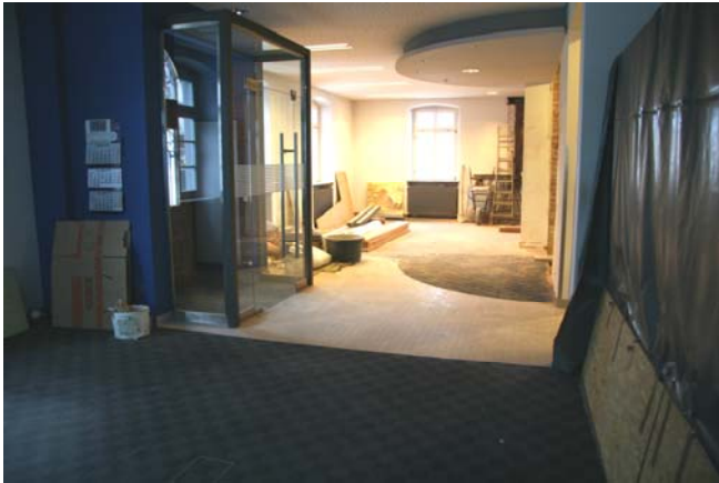
Das zukünftige Bürgerbüro im Altbau
