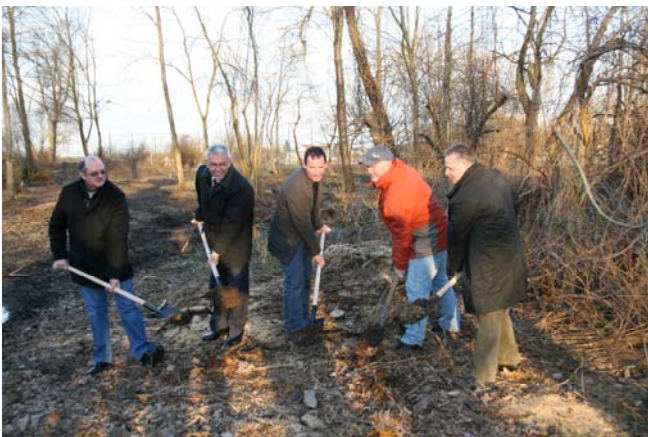
Erster Spatenstich am 22. Januar 2008
