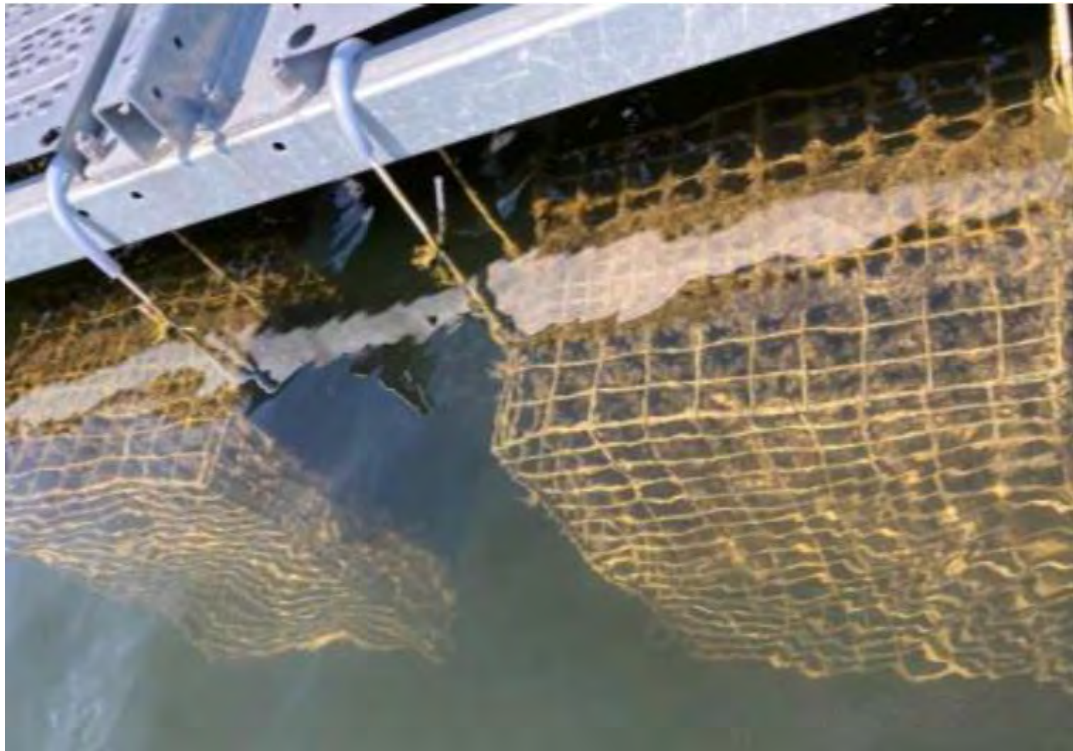
Abb. 18: Unter einer PV-Anlage angebrachte Gitterkörbe für Fische
